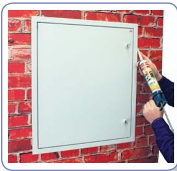
После монтажа рамки щита внутренней установки необходимо провести уплотнение с помощью монтажного силикона.
