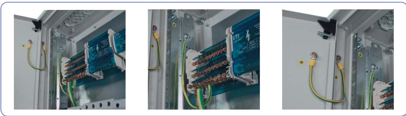
Применяя электрическое оборудование (переключатели, лампы, контроллеры и т.д.) на дверцах щита, необходимо помнить об обязательном электрическом соединении дверцы и корпуса щита. Для этих целей предусмотрены обмедненные шпильки М6х12. Щиты поставляются без блоков зажимов, распределительных блоков PE и N.
