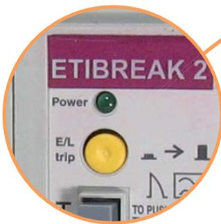
→ Светодиодная индикация наличия напряжения и индикация отключения выключателя (если желтая кнопка в ненажатом состоянии, то сработала дифференциальная защита)
